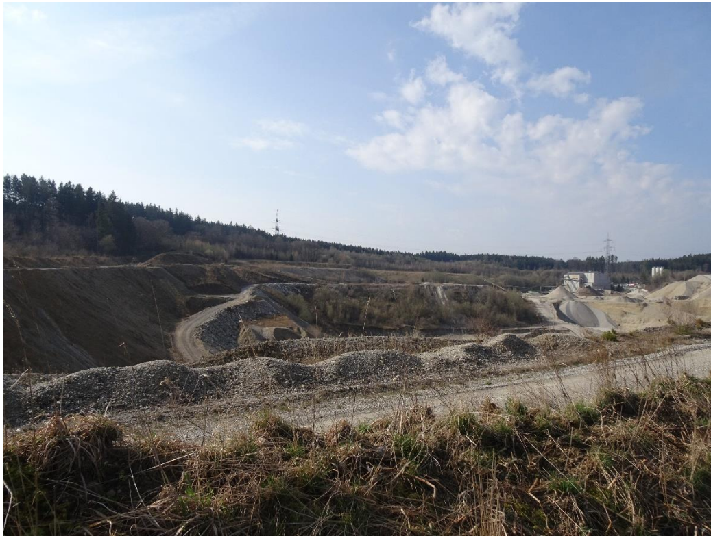
Abbildung 4: Blick über den bereits bestehenden Abbau südlich der geplanten Erweiterungsflächen. Blick in Richtung Südwesten (03/2020).
