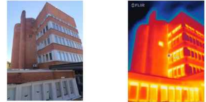
Abbildung 24: Aufnahme Außenfassade Rathaus
